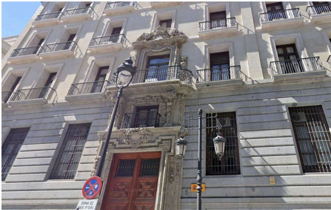
Fachada de la Dirección General de Tributos de Madrid.
